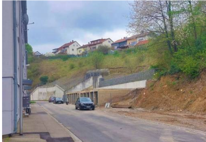
Das ehemalige Obdachlosenheim in der Kleiststraße wurde bereits bis auf die Garagen abgerissen. Foto: kuna
