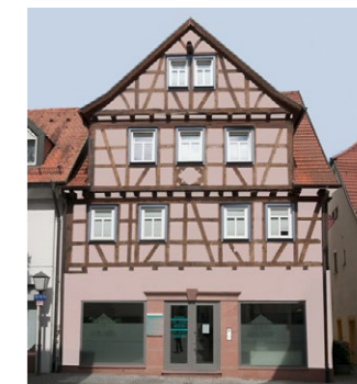
Farbanstrich mit moderater Buntheit und farblich abgestimmt auf die Natursteinverkleidung des EG
