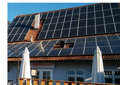
Kollektoren in gleicher Größe und Ausrichtung
