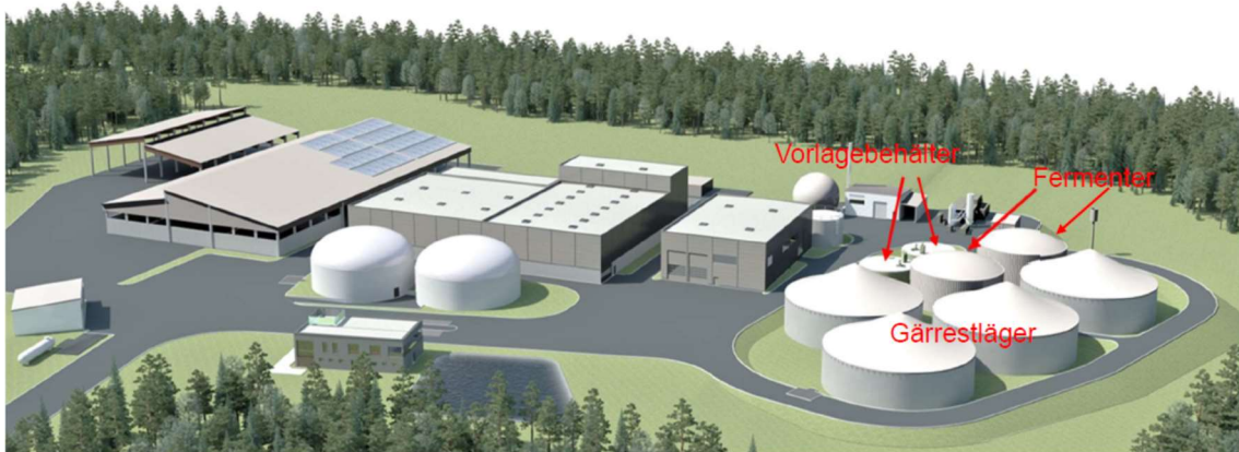
Abbildung 3: Biogaspark Großenlüder-Nassfermentation
