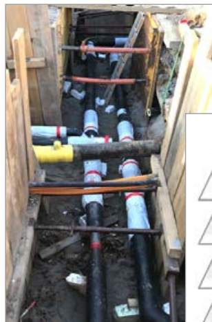
Verlegung von Wärmeleitungen
