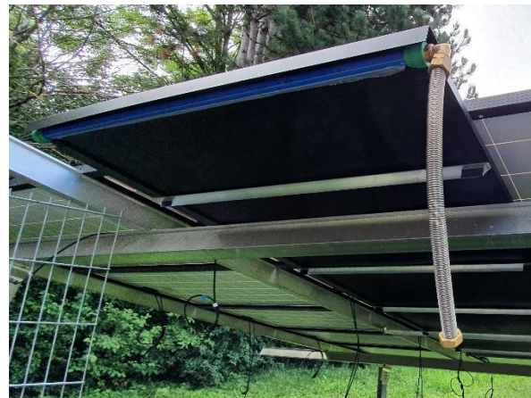
MEFA sun 1250 unter der Freiflächen PV -Montiert
