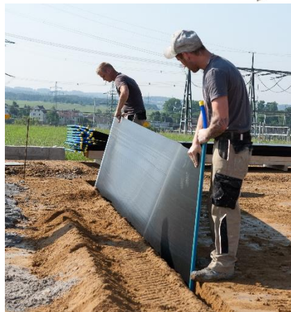
MEFA geo 1270 in gefrästen Schlitzten unter der PV Fläche eingestellt
