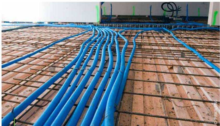
Positivbeispiel: Ein klares Leitungskonzept ist mit der Konstruktion abgestimmt.
