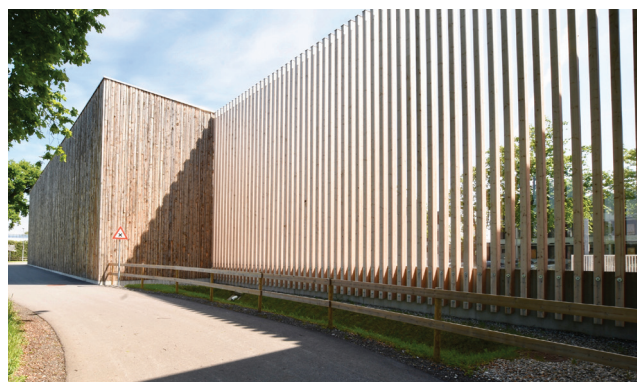
Altstoffzentrum Hofsteig, Architektur: Hermann Kaufmann Architekten ZT
